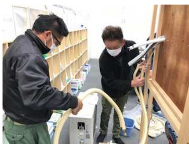
エアコン施工研修
