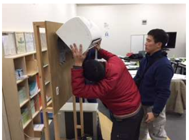
エアコン施工研修
