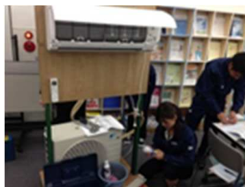
エアコン施工研修
