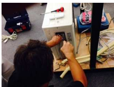
エアコン施工研修
