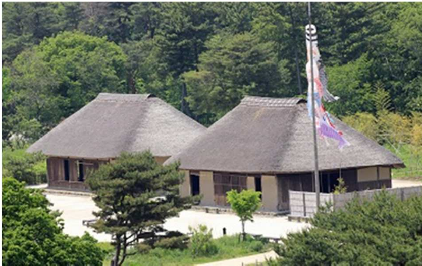
画1 茅葺き屋根 防雨水で通気と遮熱と断熱効果あり
