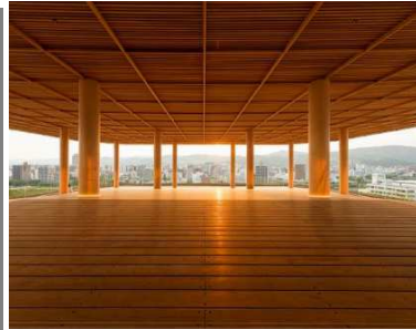
広島市おりづるタワー 屋久島市庁舎 羽黒高等学校
