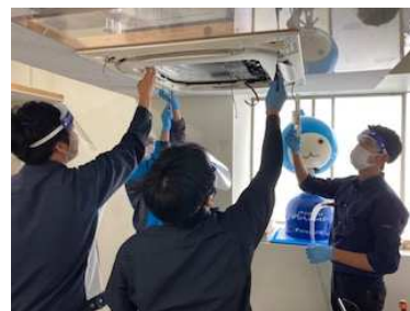
パッケージエアコン施工研修
