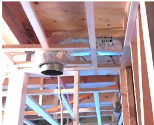
画2 キッチンダクトは要防火対策
