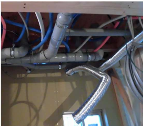
画1 一般換気蛇腹管ダクト
