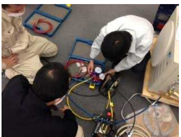
エアコン施工研修
