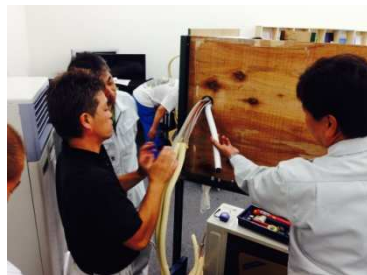
エアコン施工研修
