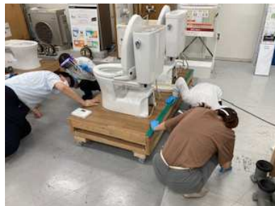
便器設置研修
