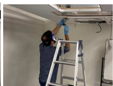
パッケージエアコン施工研修
