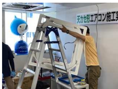
パッケージエアコン施工研修
