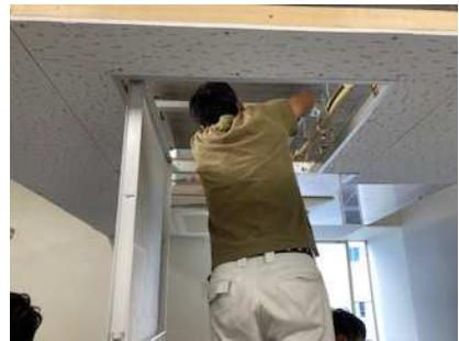
パッケージエアコン施工研修では、点検口から天井裏配管の結びを実習できます。
