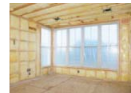
天井・壁等の断熱改修工事
